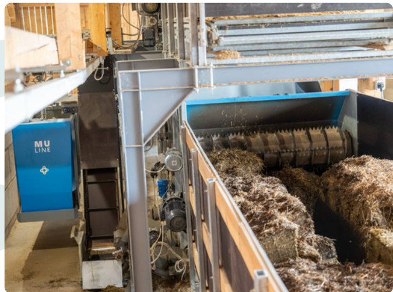
Seitenansicht des Dosiertisches und der MU LINE in Mischposition.
